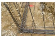
Nœud de chaînage - Continuité mécanique
