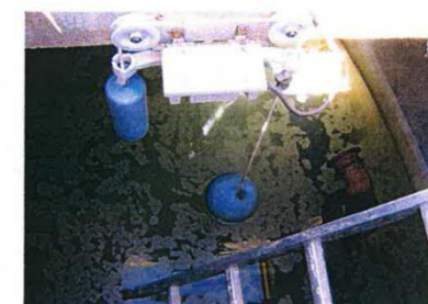
Intérieur du bassin (Régulation du niveau par flotteur)
