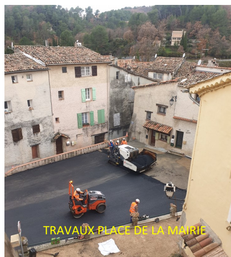
TRAVAUX PLACE DE LA MAIRIE
